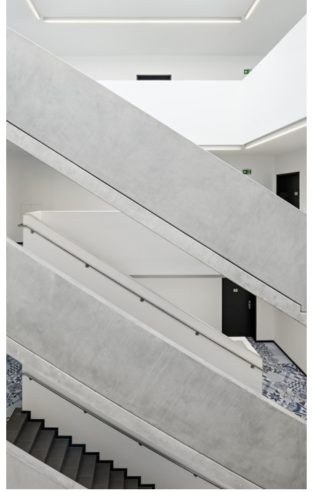
Seestadt Aspern | Baufeld D23
