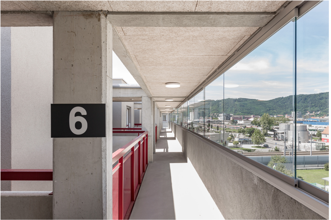
Offener Laubengang Bauteil Nord/ Open arcade building north
